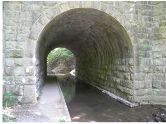
Der Tunnel, dito
